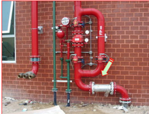
Flexible Connector เพื่อป้องกันท่อเสียหายเมื่อเกิด Differential Settlement
